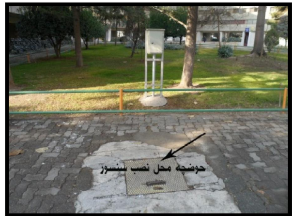
فلومترهای نصب شده در کنار خیابان بصورت سنسور و نمایشگر جدا از هم
