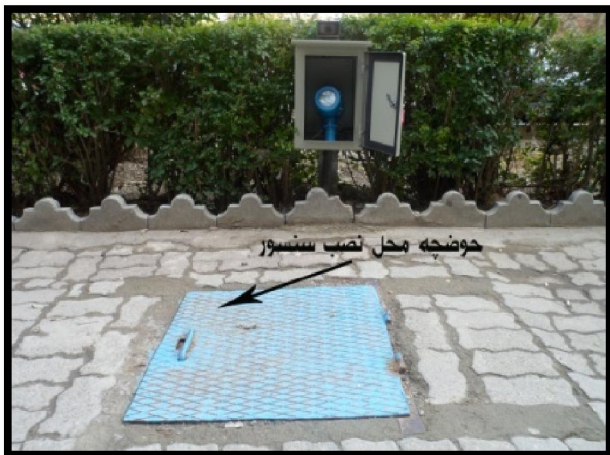
فلومترهای نصب شده در کنار خیابان بصورت سنسور و نمایشگر جدا از هم
