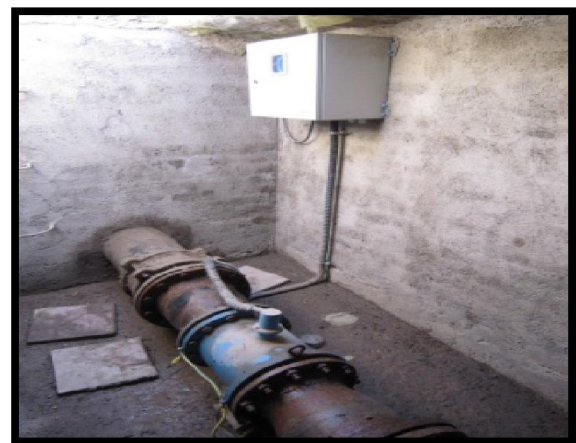
نمایشگر فقط زمانی داخل حوضچه نصب میشود که دسترسی به آن براحتی امکانپذیر باشد
