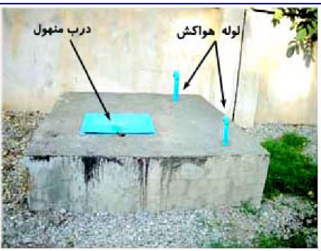
ارتفاع حوضچه از سطح زمین ۳۰ تا ۵۰ سانتیمتر جهت جلوگیری از نفوذ آبهای سطحی می باشد.
